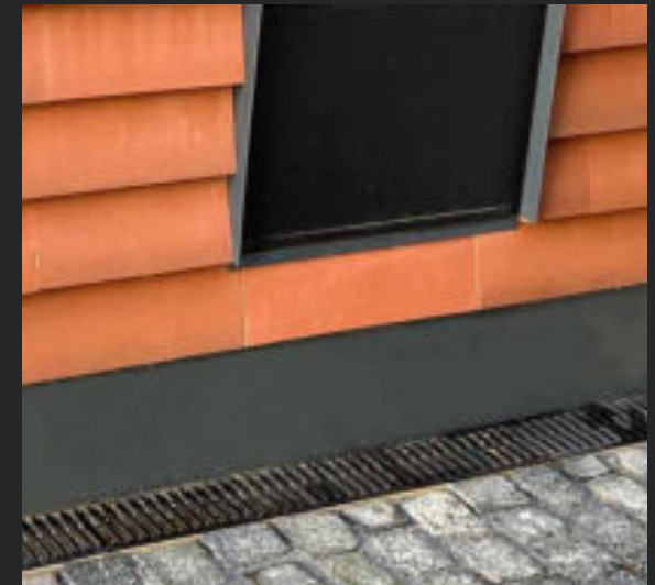
| Entwässerung im Sockelpunkt
